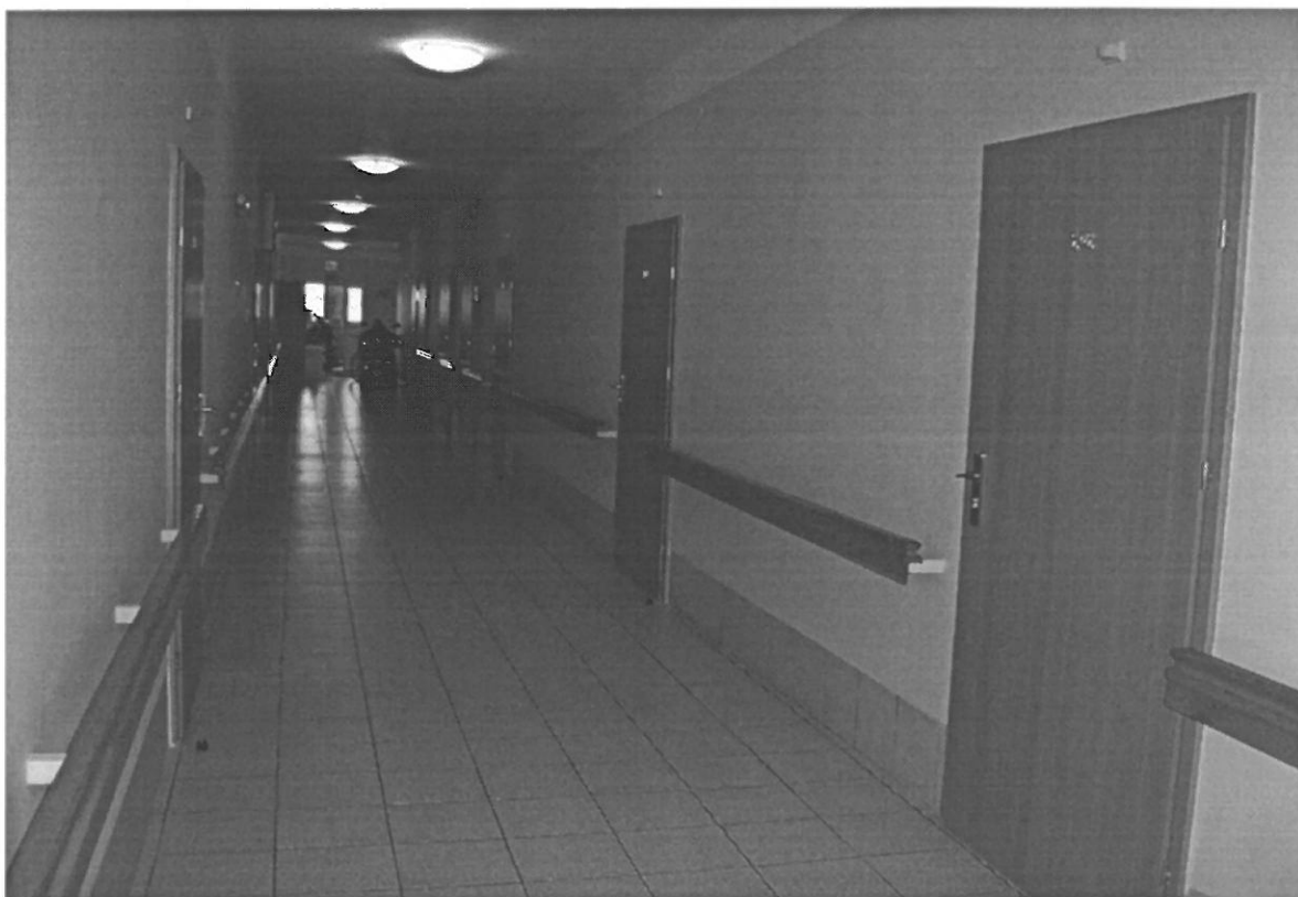
Odnowiony korytarz z wymienionymi drzwiami
